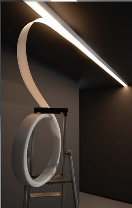
Keine sichtbaren Stöße No visible joints
